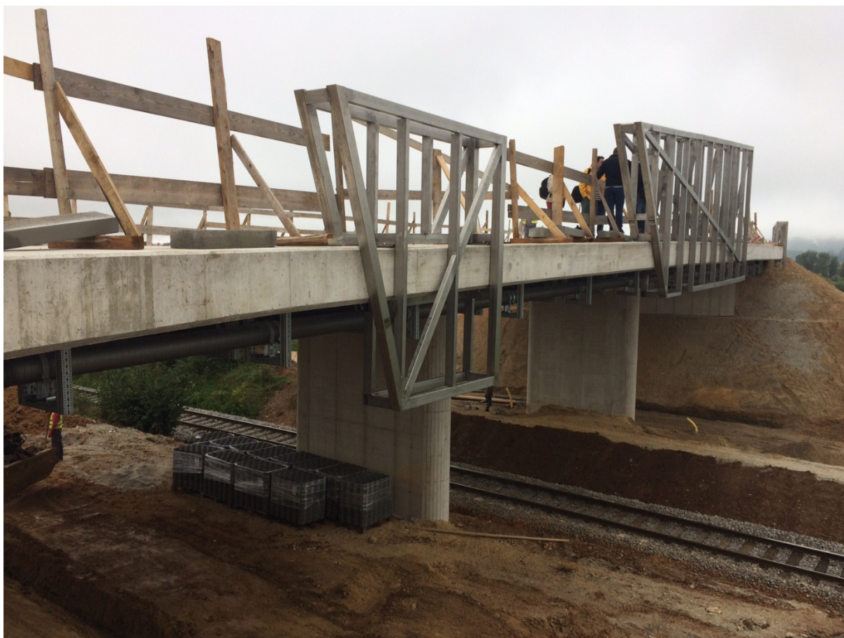
Slika 4: Nosilni sistem panelne ograje na nadvozu Brezje v Grosupljem
